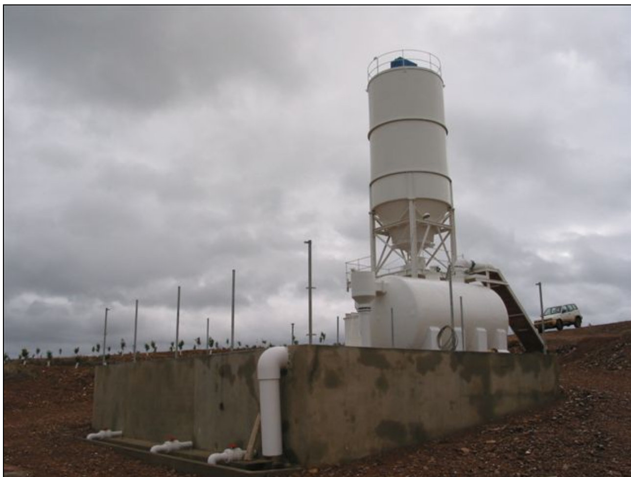
Foto 4: Vista Planta Tratamiento de Aguas.
