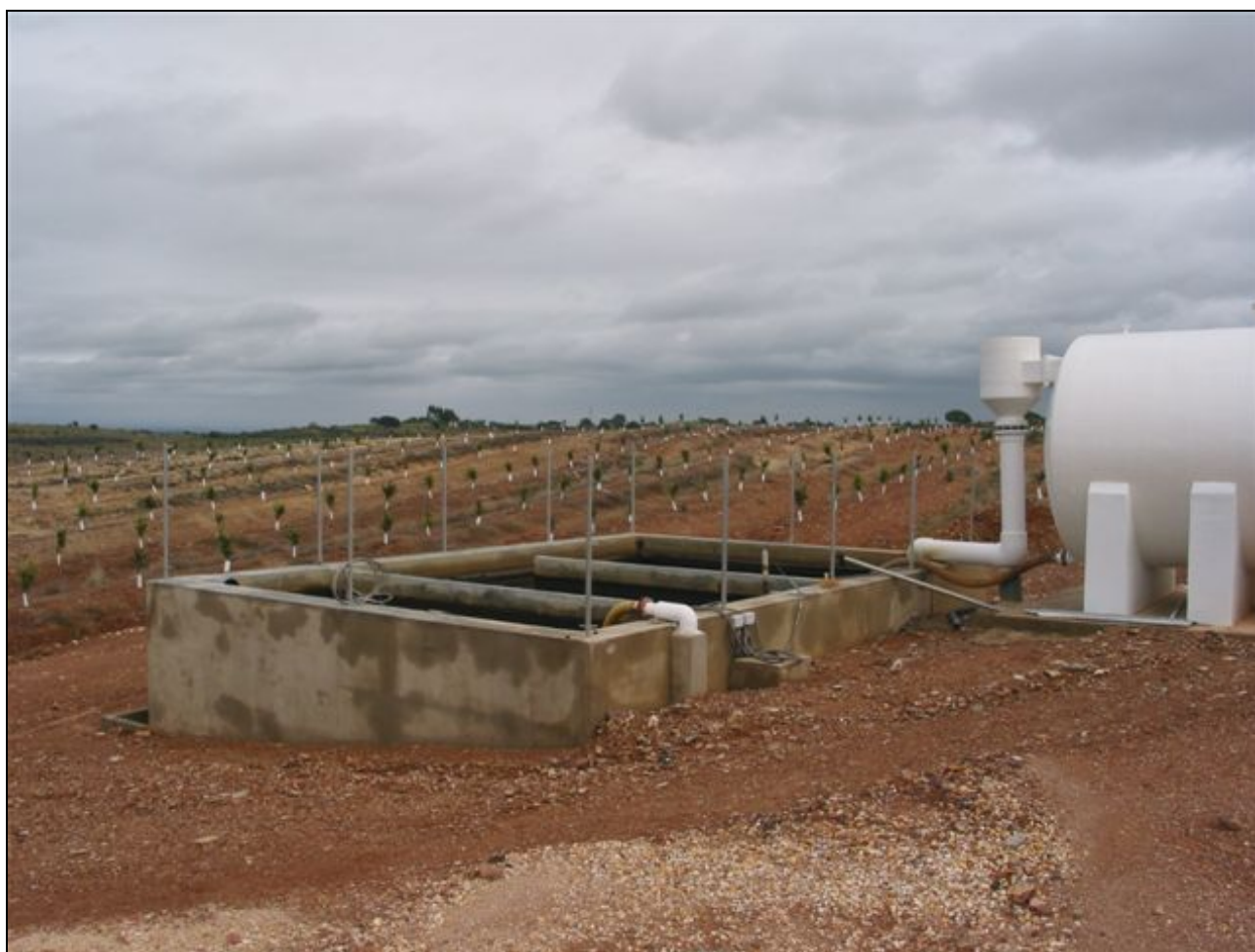
Foto 5: Vista Planta Tratamiento de Aguas
